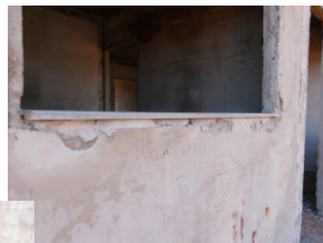
Incompatibilidade entre vão previsto em projeto e esquadria comprada
