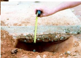
Altura do enrijecedor de 16 cm, inferior ao especificado em projeto ( 30 cm. )
