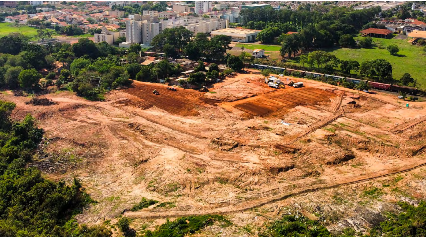
São José do Rio Preto – Favela Marte em obras.
