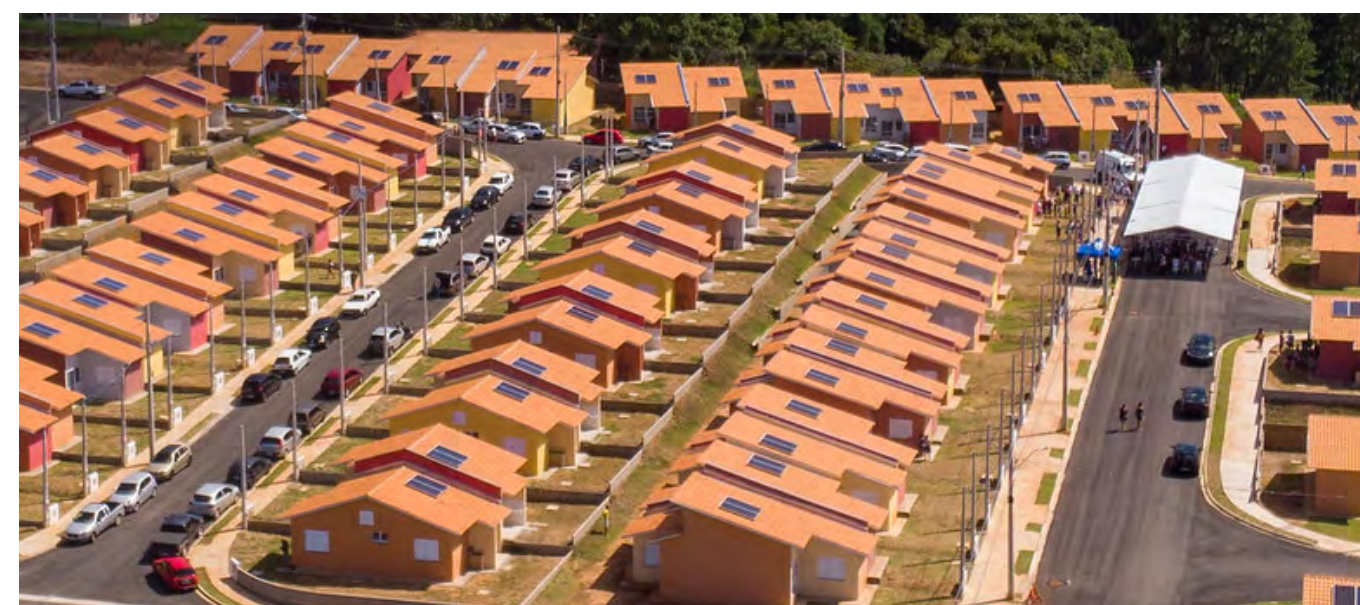
Empreendimento Torre de Pedra – unidades com placas fotovoltaicas.
