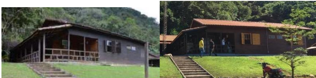
Foto 7 - Recuperação de caixilhos e estrutura de madeira
