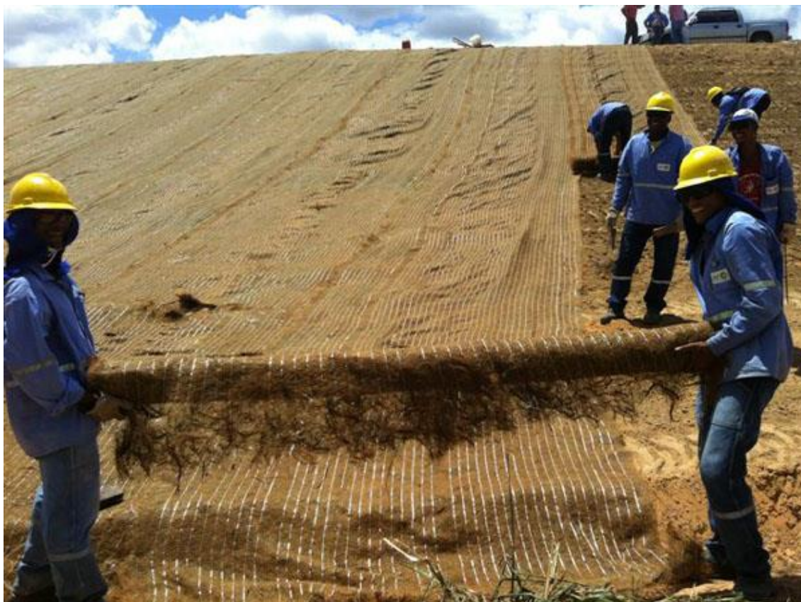
Foto 3 – Exemplo de aplicação de biomanta em active
