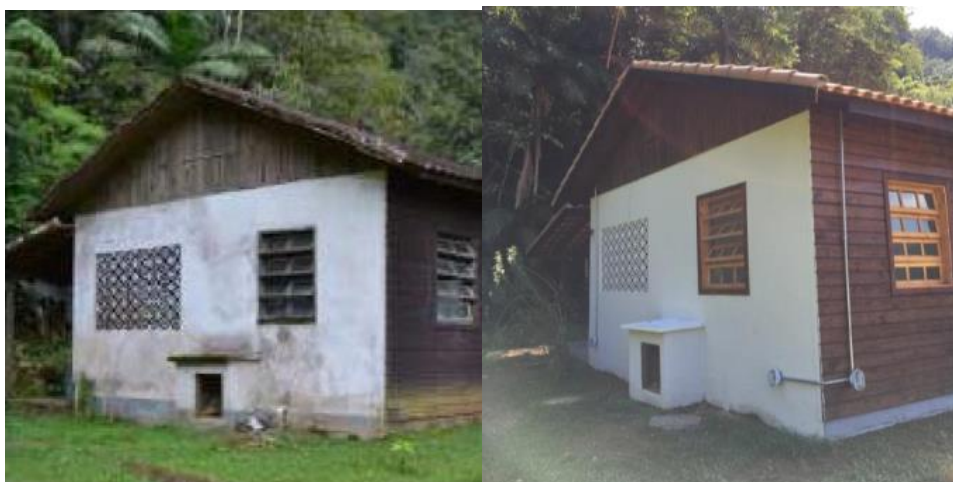
Foto 8 - Recuperação de fachadas
