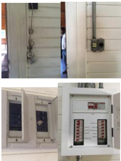
Foto 12 - Adequação de infraestrutura elétrica
