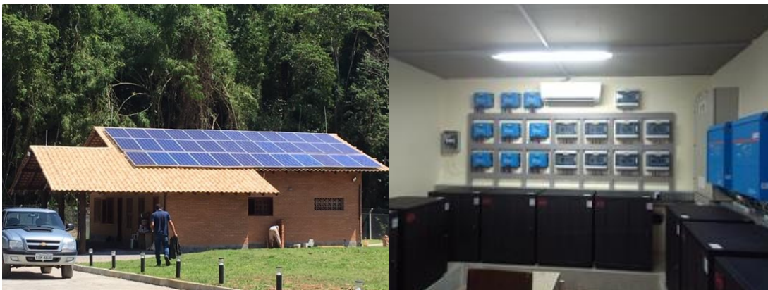
Foto 4 - Instalação e modernização dos sistemas de geração de energia fotovoltaica
