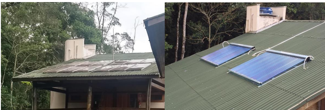
Foto 5 - Instalação e modernização de sistemas solares de aquecimento d'água
