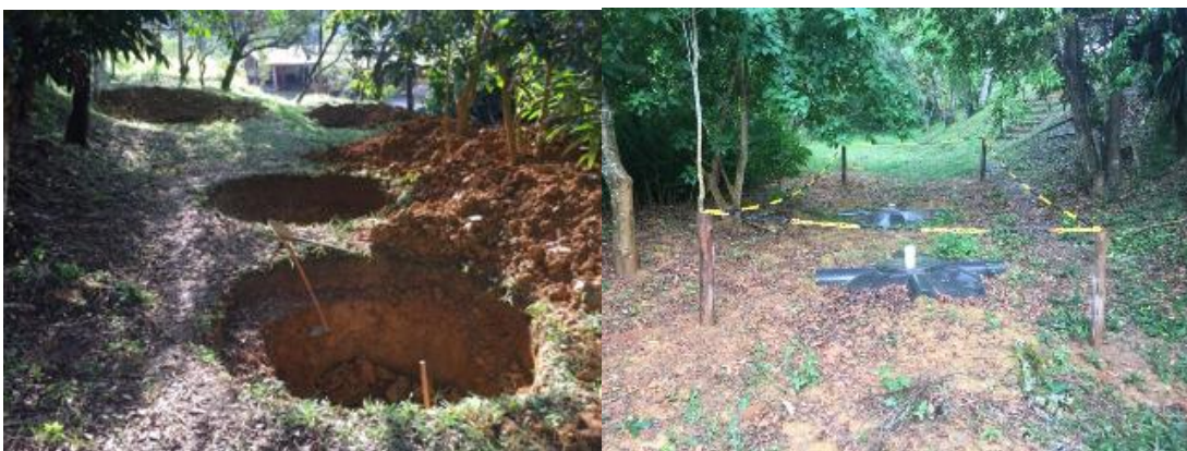
Foto 6 - Instalação ou adequação dos sistemas de tratamento de esgoto
