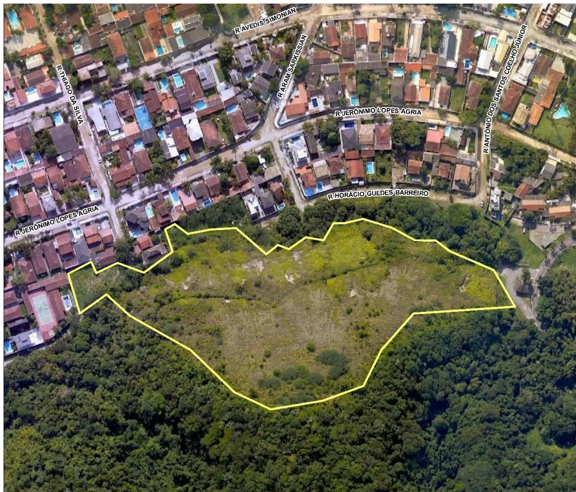
Figura 4 – Recuperação geotécnica-ambiental do Morro do Pinto
