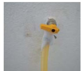
A formação de bolhas indica que há vazamento de gás. Se isso ocorrer, aperte novamente as abraçadeiras e repita o teste. Se a situação persistir, peça ajuda do responsável pelo condomínio ou da empresa concessionária de gás para verificar o problema e solucioná-lo. Enquanto houver vazamento, você não deve abrir o registro.
