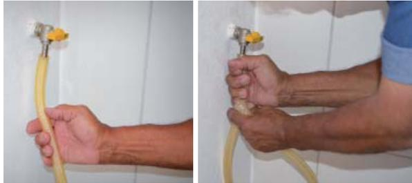
Encaixe um dos lados da mangueira no registro da parede, ajustando-a até chegar ao final do adaptador.
